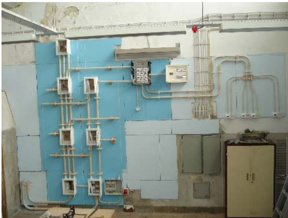
Nova panorâmica geral do trabalho efectuado.
